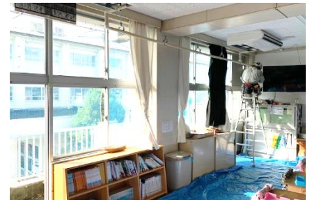
11月：機器の取り付け工事
