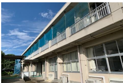
12月・1月：室外機の取り付けと固定工事
