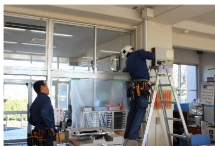
2月：職員室のコントローラー設置工事
